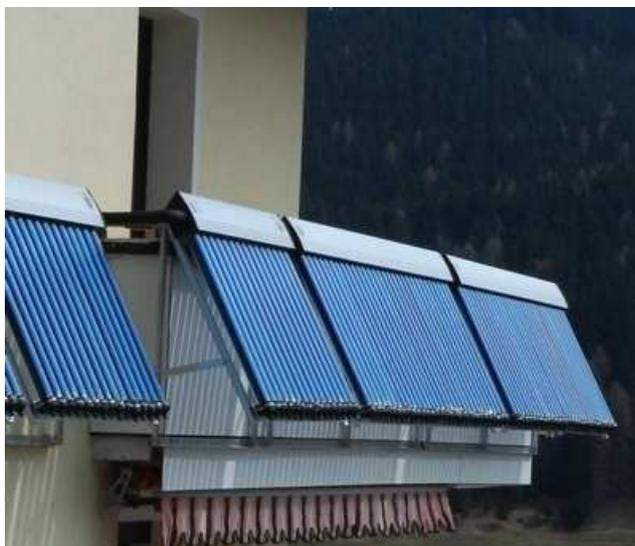
**Abbildung 35: Vakuümrohrenkollektoren an Fassade und Balkon**
